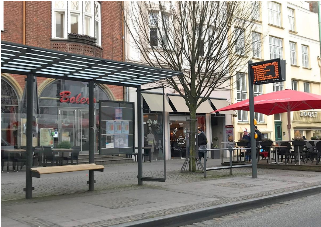
Abbildung 5: Haltestelle mit DFI-Anlage und Außenansage für Sehbehinderte
