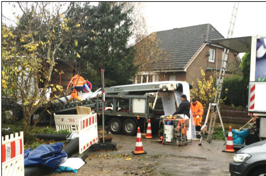
Kanalsanierung Hauptsammler Finkenbergr
