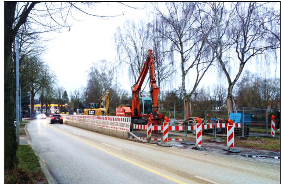
Ersatzneubau DRL Brandenbaumer Landstraße
