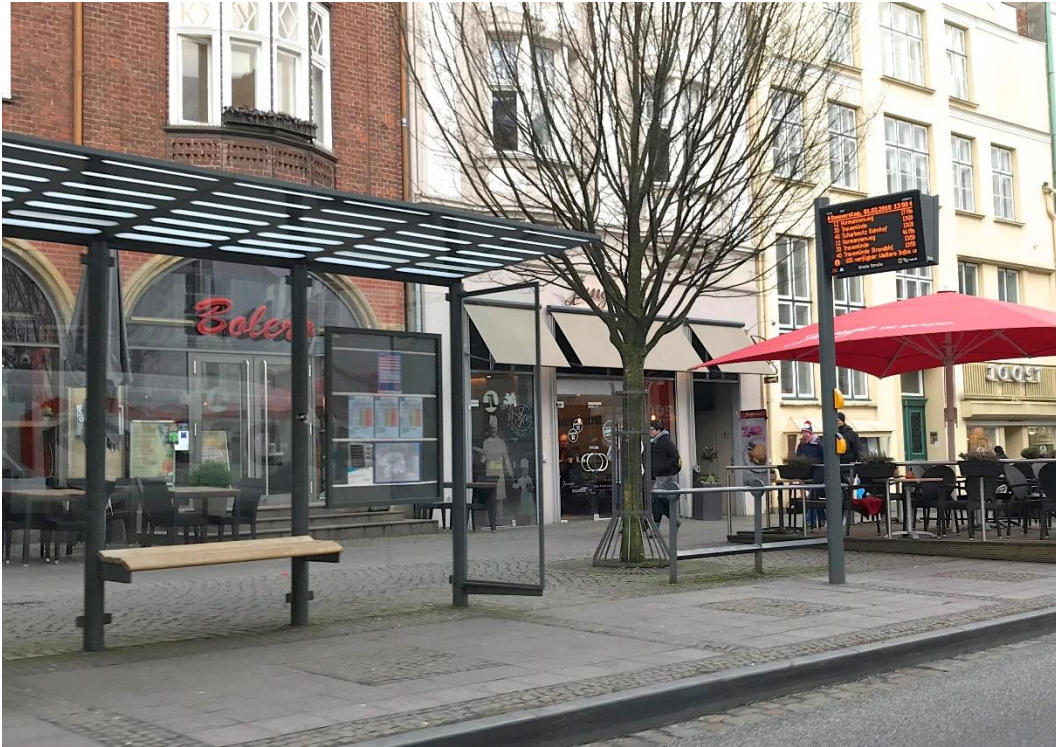
Abbildung 5: Haltestelle mit DFI-Anlage und Außenansage für Sehbehinderte
