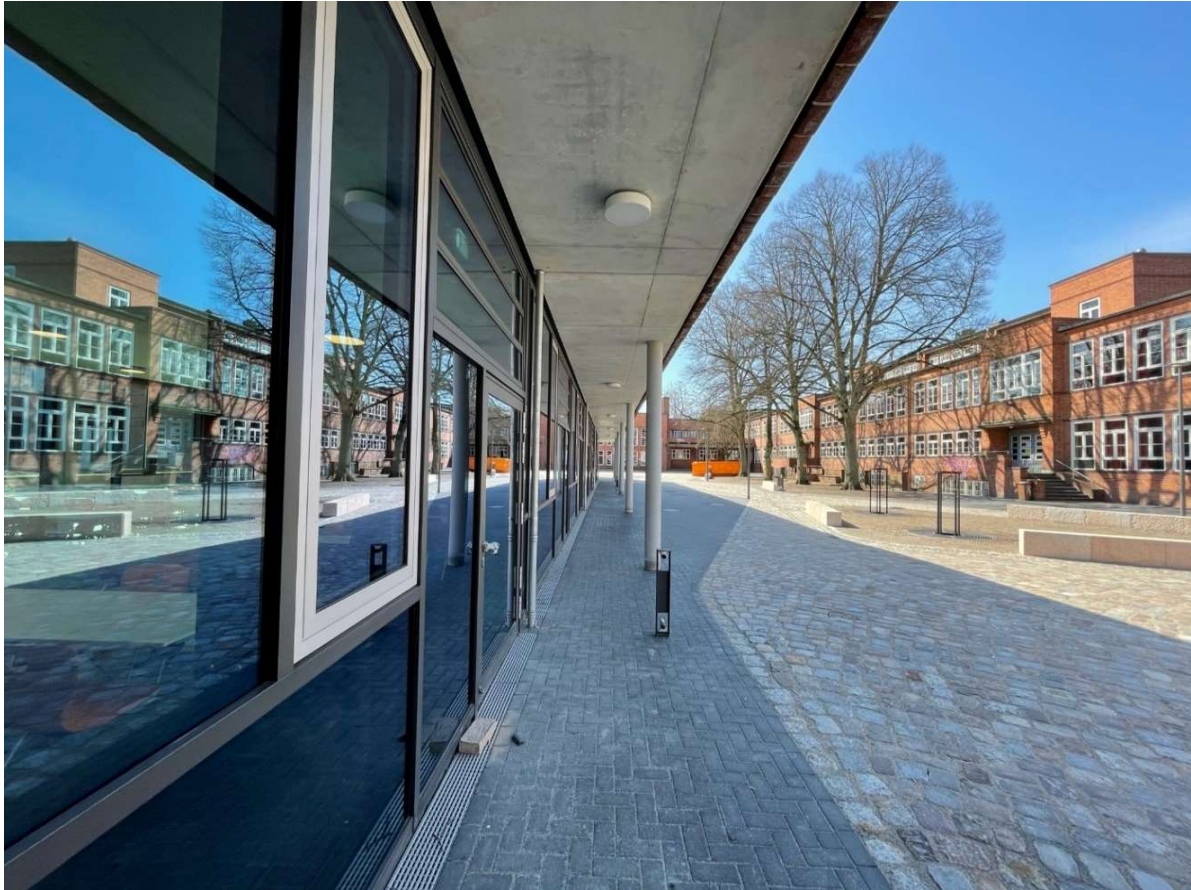
1-geschossige Mensa-Fassade (vom Schulhof)
