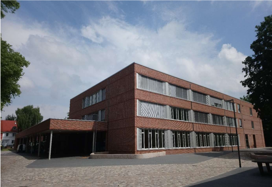
3-geschossiger Neubau mit Eingang (vom Schulhof)
