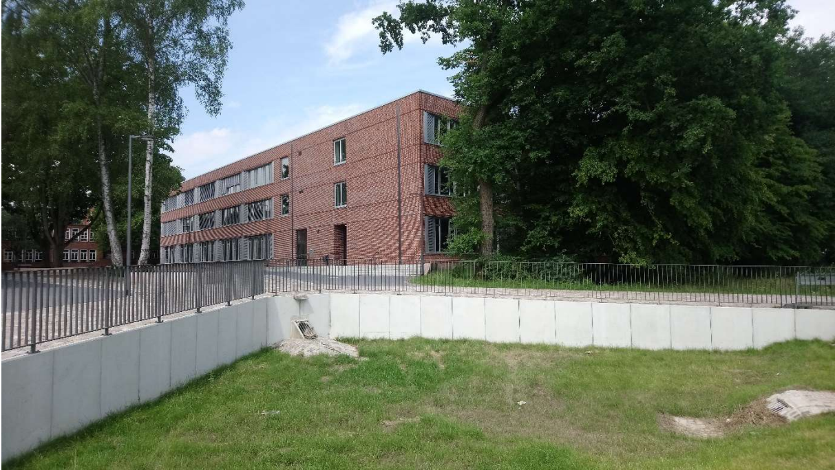
Ausbaulaufwerk (Regenversickerung in mehreren Mulden)
