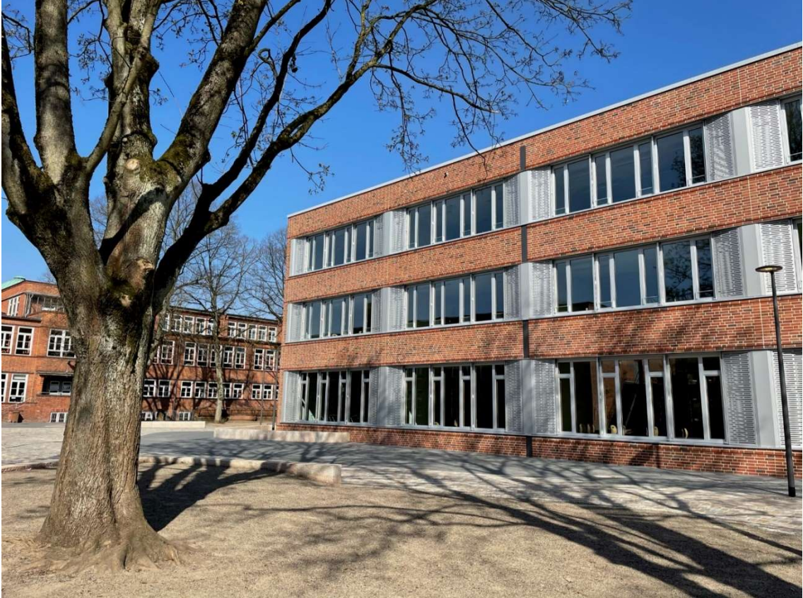
Neubau mit Altbau im Hintergrund
