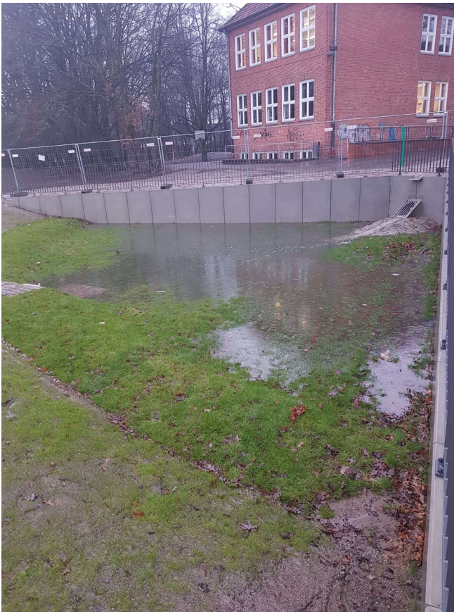
Ausbaulaufwerk nach starkem Regen (hier noch Bauphase)
