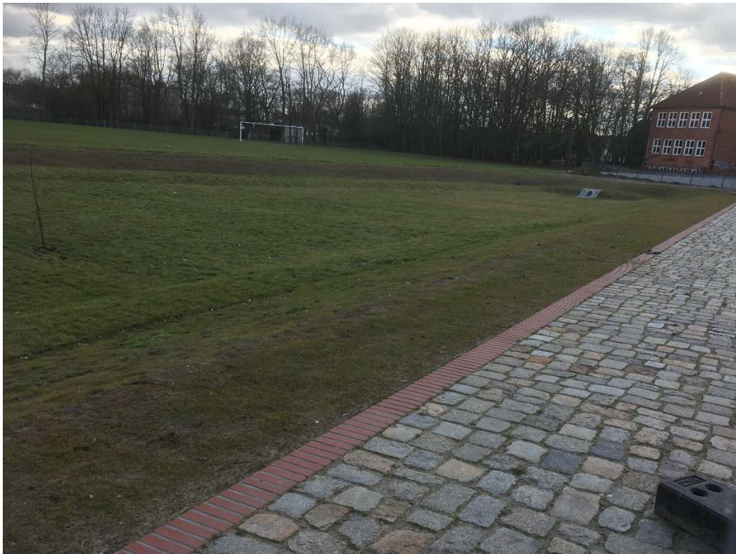
Regenversickerung in mehreren „Mulden“ (geformte Schulhoffläche)
