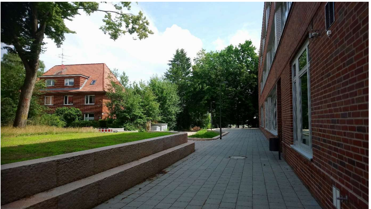
Oberstufenschulhof: im hinteren Teil fehlt noch Außenmöblierung
