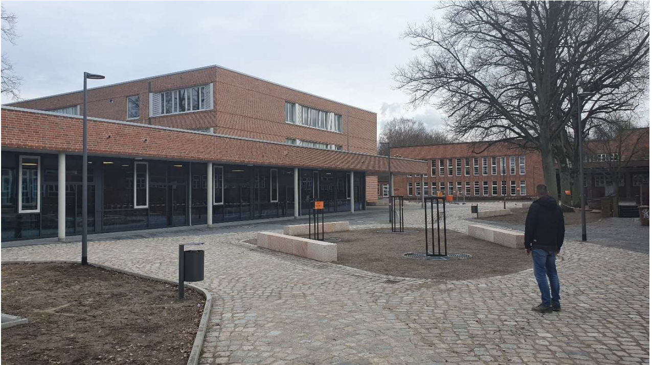
Eingangsbereich Schulhof: fehlende Vegetation
