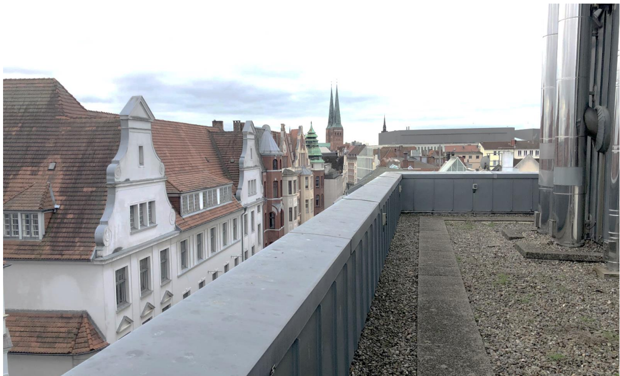
Ansicht Dachgeschoss / Dachterrasse (Richtung Königstraße)
