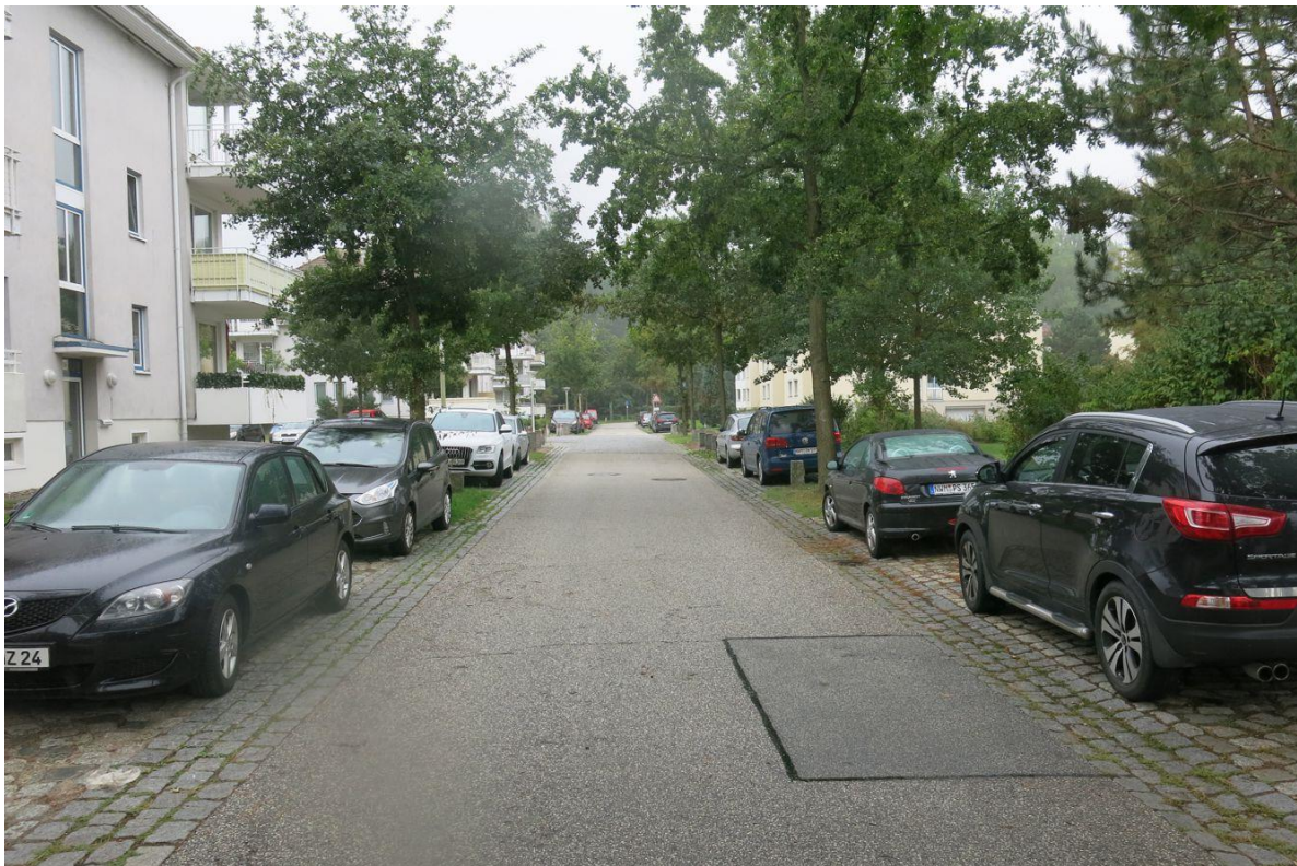
Bild 4: Längsparken in Parkbuchten in der Straße Alte Werft
