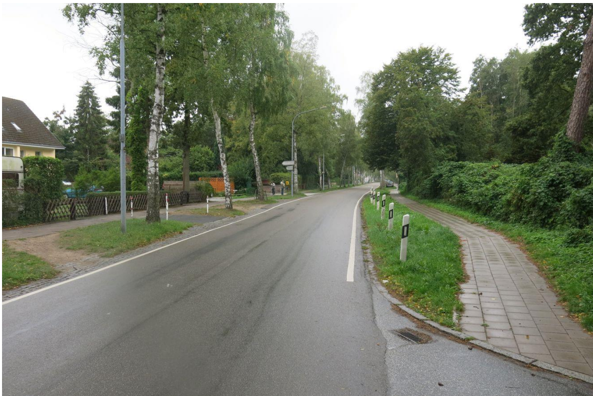
Bild 10: Straßenquerschnitt der Mecklenburger Landstraße zwischen Meeresrauschen und Wiekstraße (Einfahrt Feriendorf Strand)
