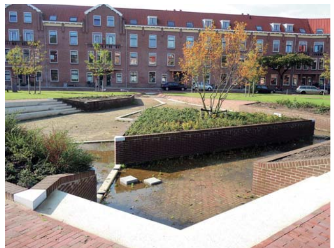
Abb. 10: Beispiel für eine temporär wasserspeichernde Grünfläche im Falle eines Starkregens in Rotterdam (siehe M18).
