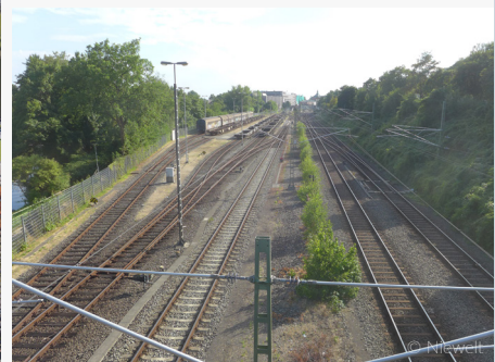
Abb. 30: Brachliegende Flächen, Gleisstrassen als Barriere (Abb. 52 aus Masterthesis Niewelt)
