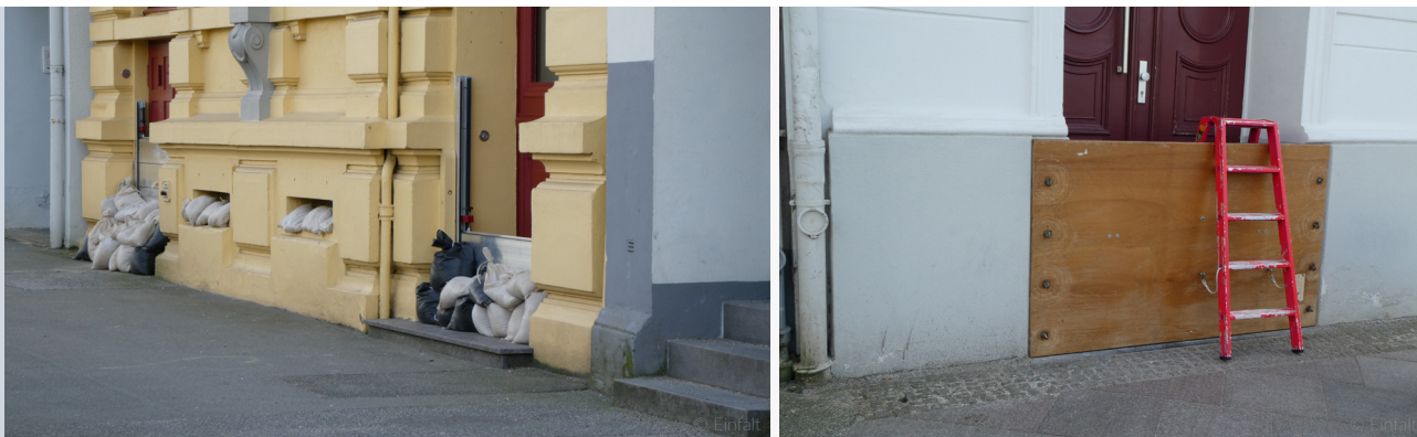
Abb. 21: Selbsthilfemaßnahmen bei Hochwasser an der Obertrave
