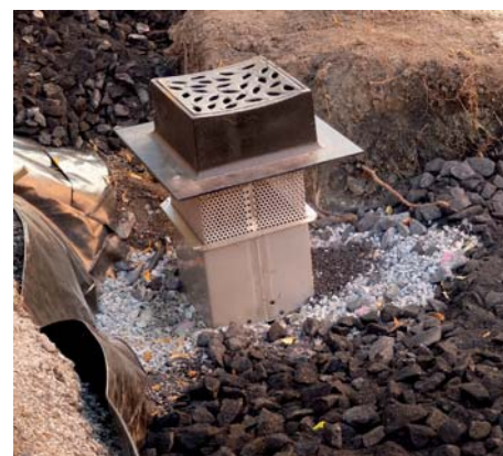
Abb. 17: Gezielte Versickerung von Regenabflüssen in den Pflanzgruben der Straßenbäume in Stockholm. Wichtige Elemente sind dabei grob gebrochener Schotter mit Oberboden gemischt sowie ein Be- und Entlüftungsschacht, der ebenfalls zur Bewässerung dient.
