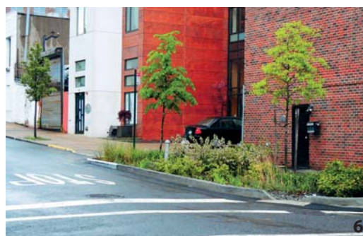
Abb. 12: Verschiedene Anpassungsmaßnahmen für den Neubau und den Bestand (von links nach rechts): Entsiegelung und Begrünung von Vorgärten (1), nachträgliche Versickerungsmulde (2), temporärer Rückhalt von überschüssigem Wasser bei Starkregen auf einem Schulhof (3), Wasserinstallation (4), nachträglich begrüntes Hoteldach (5), nachträgliche Versickerungsflächen in einer Straße (6)
