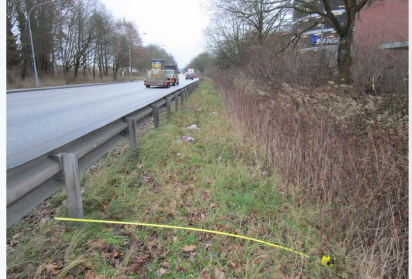
bereits sanierter Fahrbahnbereich auf Höhe CITTI-Park, Entwässerungsgraben, Blickrichtung stadteinwärts
