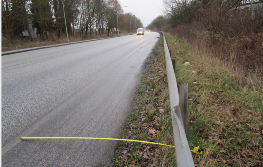
bereits sanierter Fahrbahnbereich mit Schutzplanke auf Höhe CITTI-Park, Blickrichtung stadteinwärts
