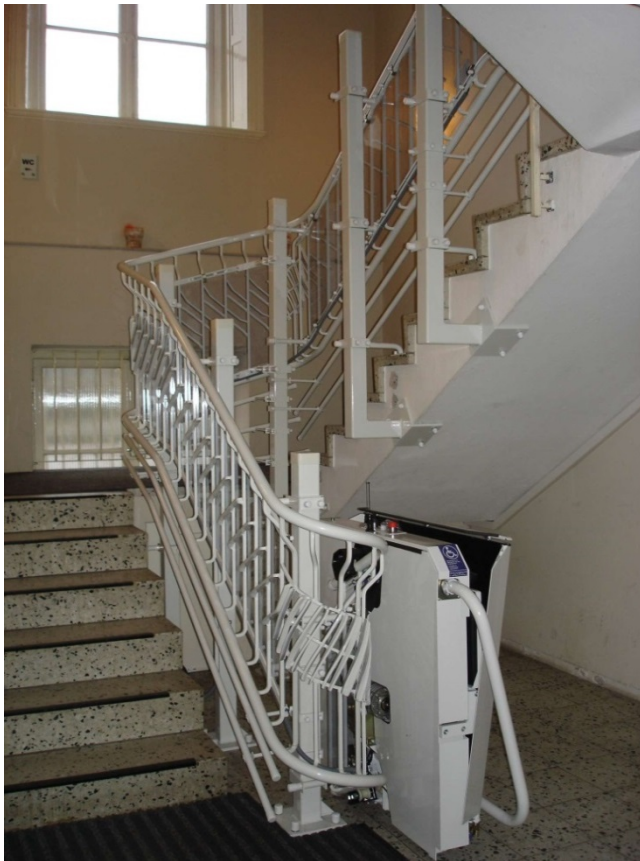
Treppenlift Villa (Bestand)
