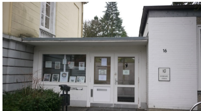
Haupteingang und Verbindungsbauwerk
