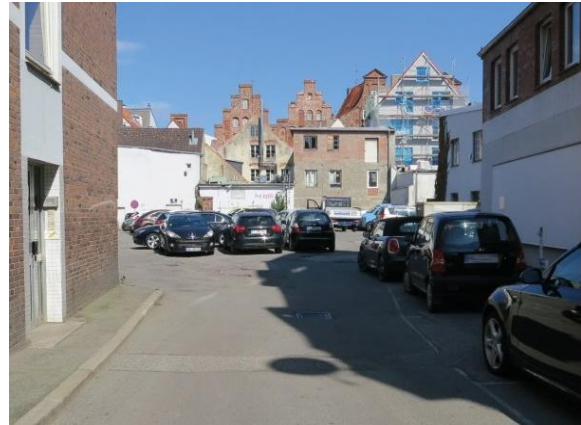
Abb. 41: Blockinnenhof Aegidienstraße 25-27 – Völlig ungeordneter und desolater Blockinnenbereich
