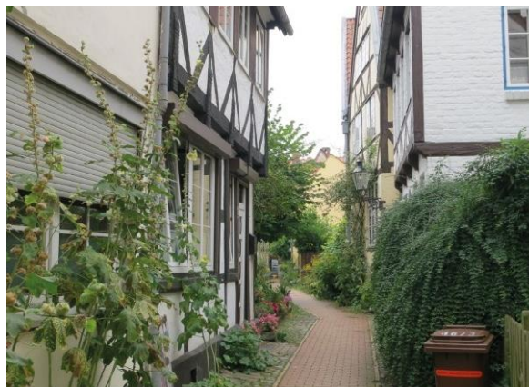
Abb. 29: Durchgang – Strukturprägender Gang und Hof
