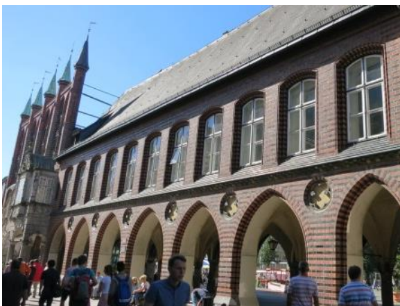
Abb. 26: Rathaus, Gebäudeteil A „Langes Haus“
