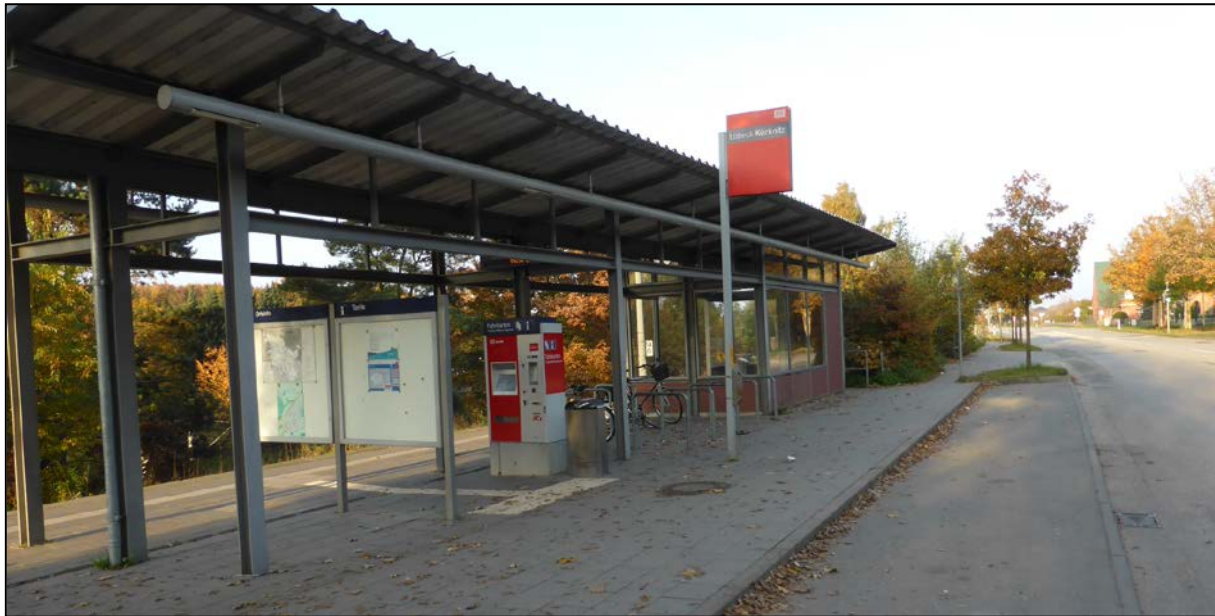
Bahnhof Kücknitz mit Fahrgastunterstand (2015)
