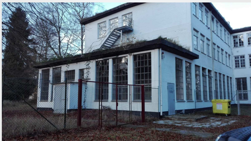
04 Gebäude Industriehalle, Speckmoorstraße 6
