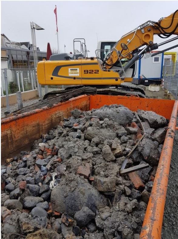
Hindernisse aus der Rammtrasse
