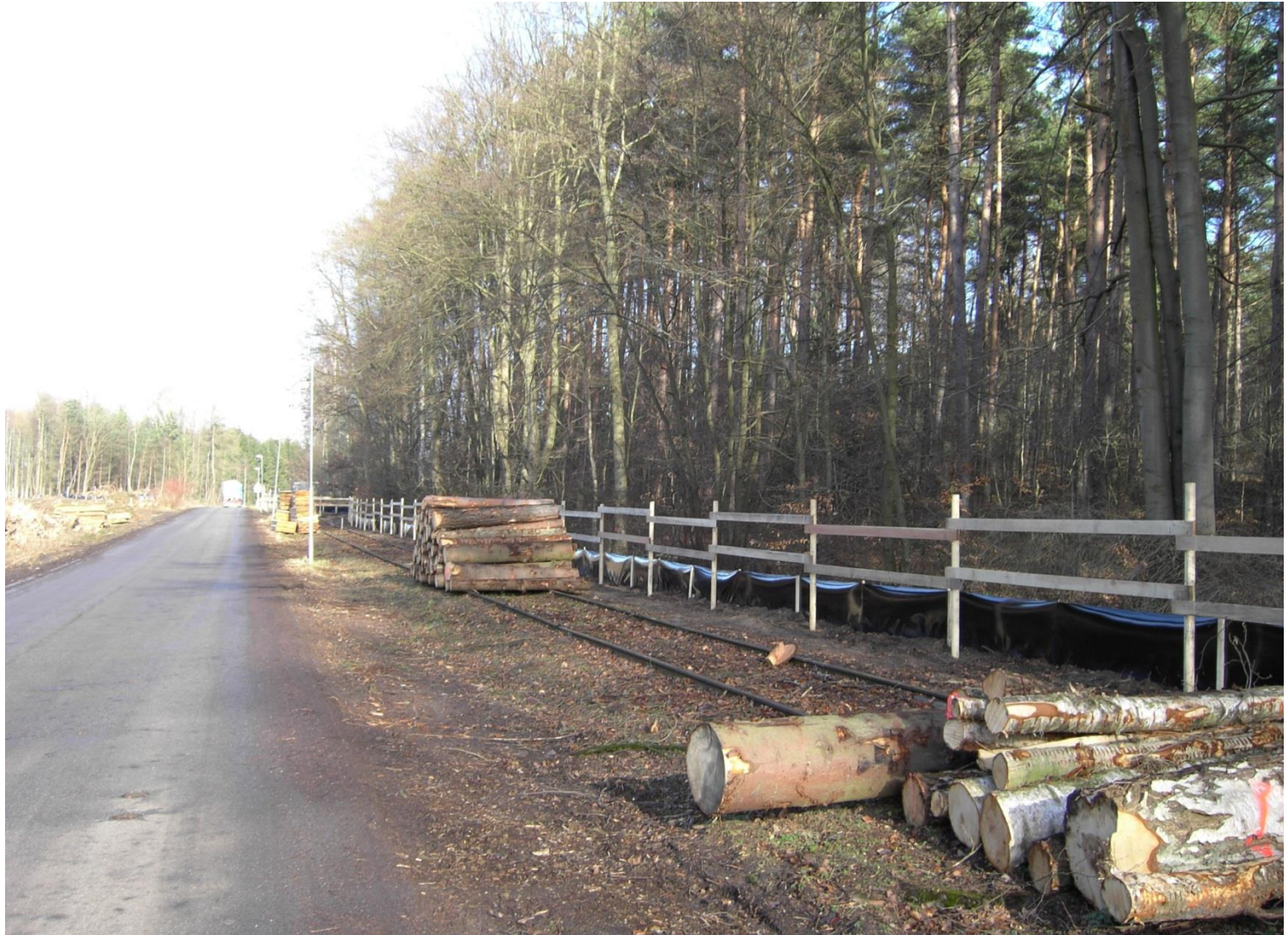
Amphibien-Leiteinrichtung mit Tabu-Zonen-Schutz
