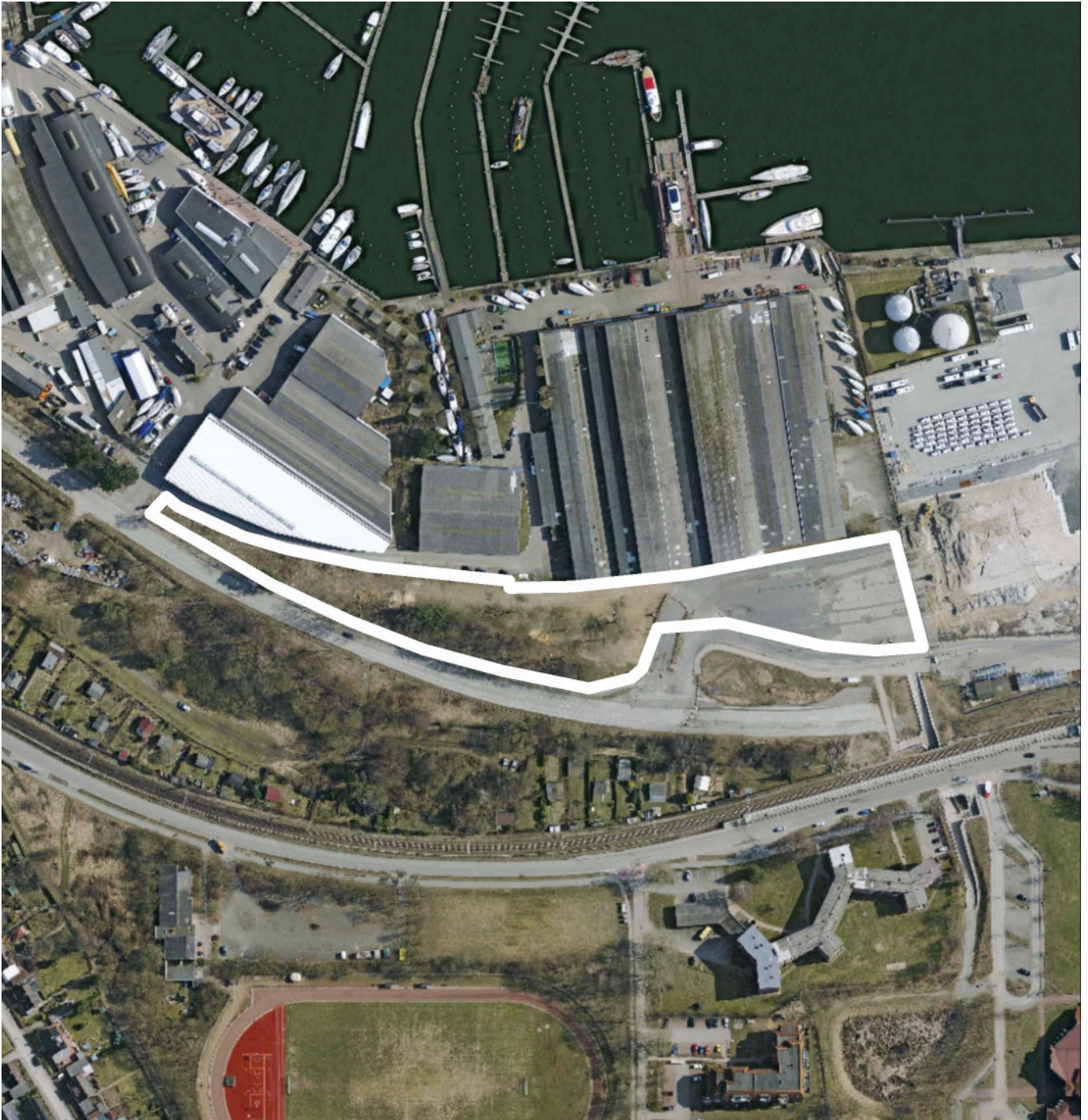
Abb. 30 Logistikfläche vor der Böbswerft auf dem Skandinavienkai
