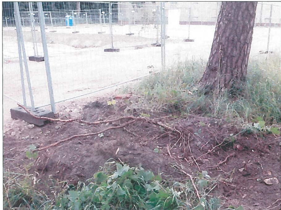
Abb. 2: Durch Rodungsarbeiten freigelegte und aus dem Boden herausgelöste Kiefer-Wurzel
