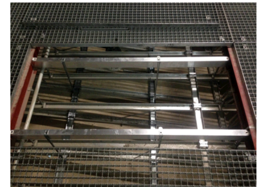
Übersicht der Struktur eines sanierten Deckenfeldes
