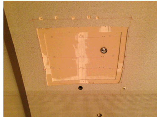
Freilegung der einzelnen Gipskartonlagen
