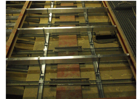
Ersatz der alten Überbrückung im Bereich der Stahlträger durch neue Grundprofile und Abhängung
