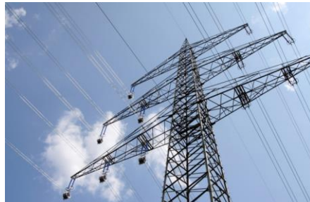
Strom, Gas, Wärme
