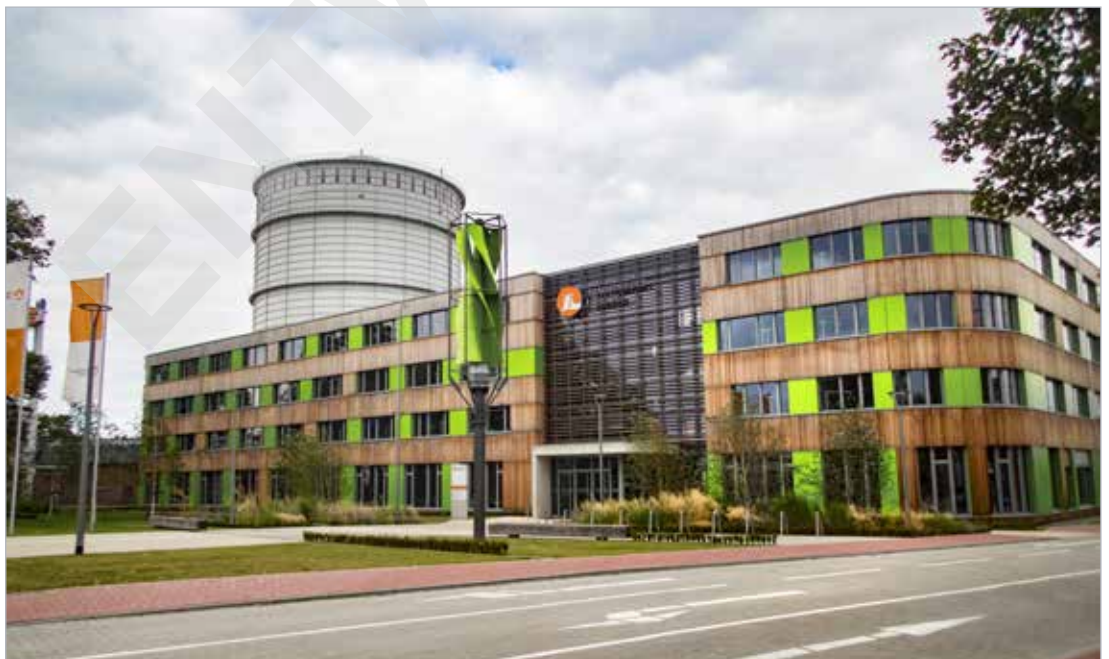
Abb. 7 | Hauptgebäude der Lübecker Stadtwerke GmbH an der Geniner Straße; im Hintergrund der Gasometer
