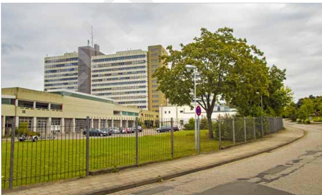
Abb. 4 | Blick auf das Behördenhochhaus (mit Parkdeck) von der Hans-Böckler-Straße/Ecke Welsbachstraße
