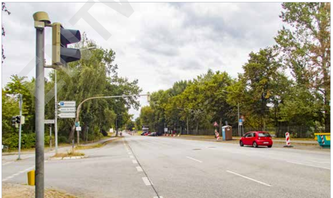
Abb. 5 | Possehlstraße/Ecke Welsbachstraße, Blick in Richtung Nordwesten zur Possehlbrücke
