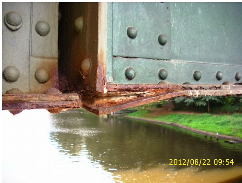
Abb. 9 Verformung durch Blattrostbildung und Zwängung
