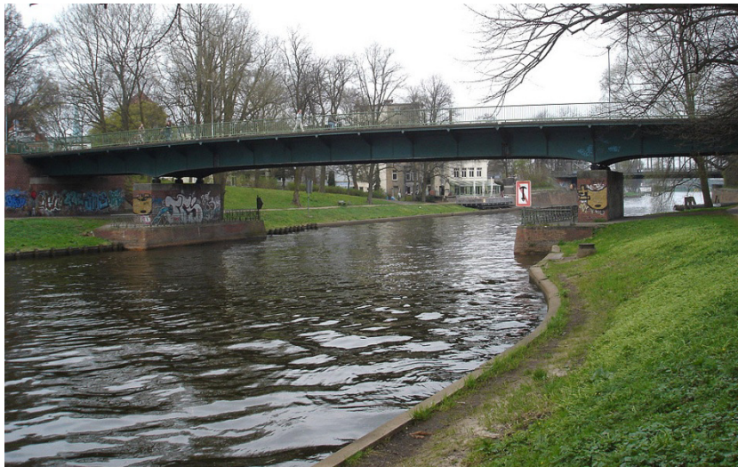
Abb. 1 Südsicht des Bauwerks
