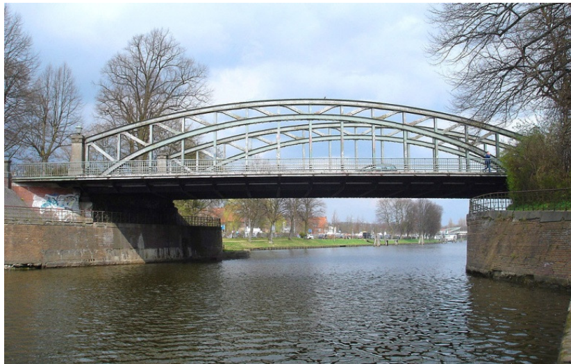
Abb. 1 Südansicht des Bauwerks
