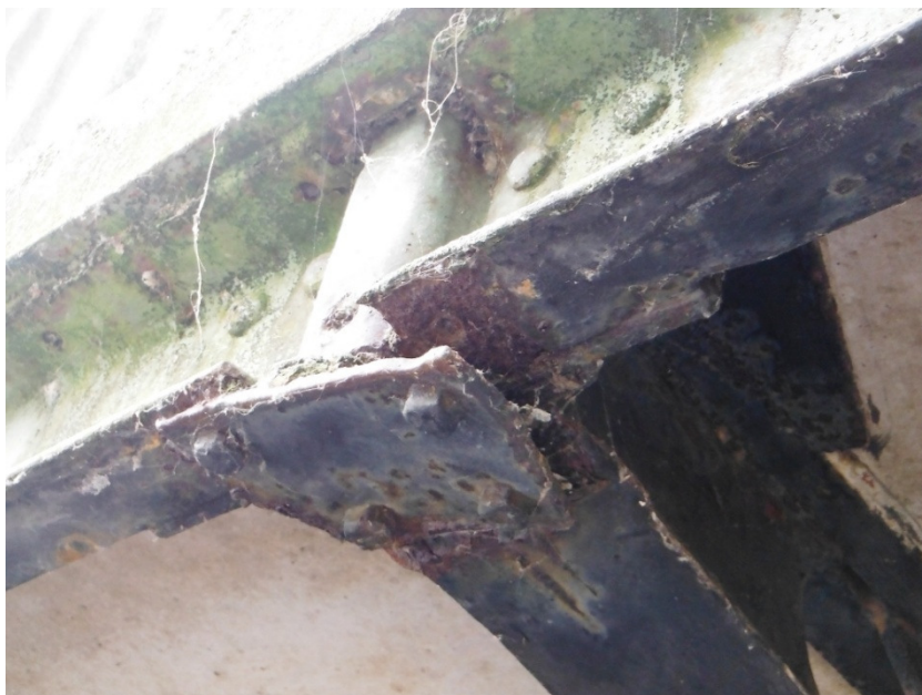
Abb. 8 Sprengwirkung durch Blattrostbildung
