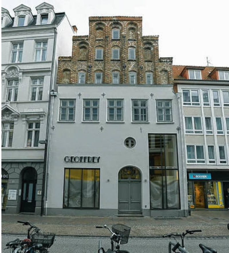
Zeitpunkt: 2015, Quelle: LN
