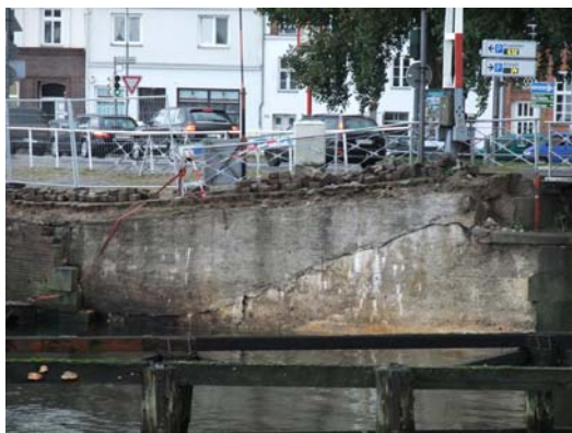
Ansicht Ufermauer nach Abriss Vorsatzschale
