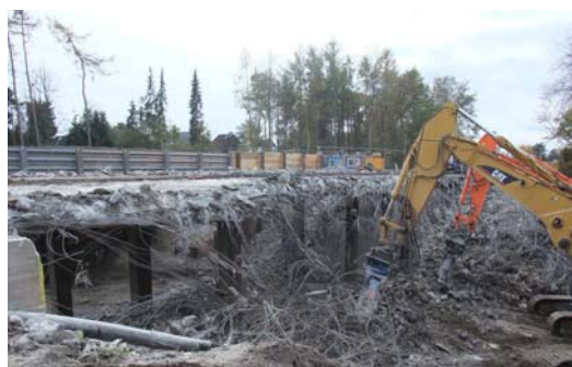
Abbruch Überbau und Stützen
