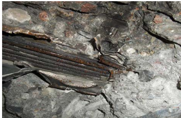
Detailaufnahme Spannglied Entnahmestelle 1
