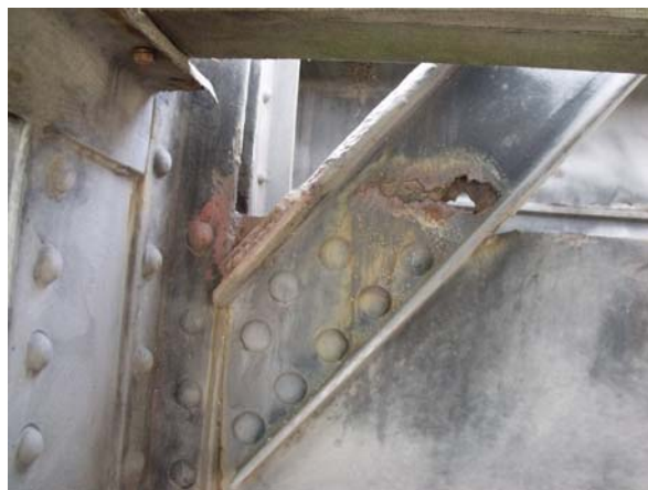
Hafendrehbrücke – Korrosionsschäden
