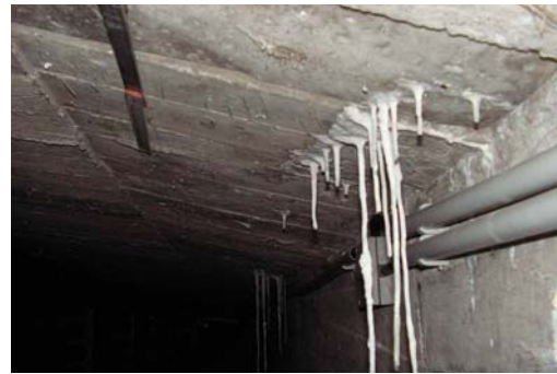
Aussinterungen im Hohlkasten Ost
