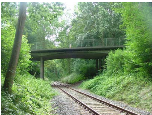
Seitenansicht Straßenbrücke Wesloe
