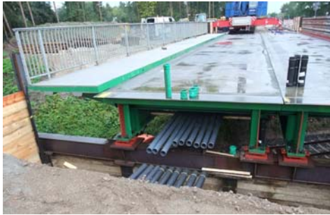
Behelfsbrücke (Auflagerkonstruktion, Leerrohre)
