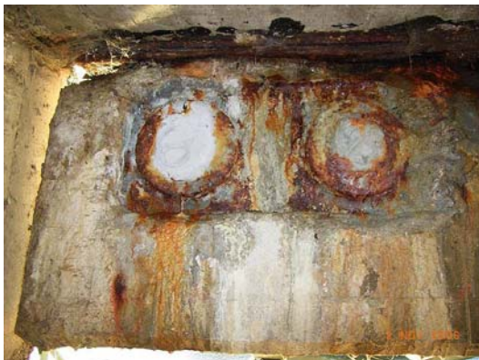
Freiliegende Spannköpfe
