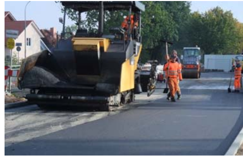
Asphaltarbeiten zur Herstellung der Umfahrung
