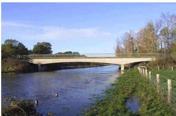
Seitenansicht Straßenbrücke Reecke
