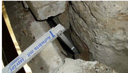
Kammerwandverformung
